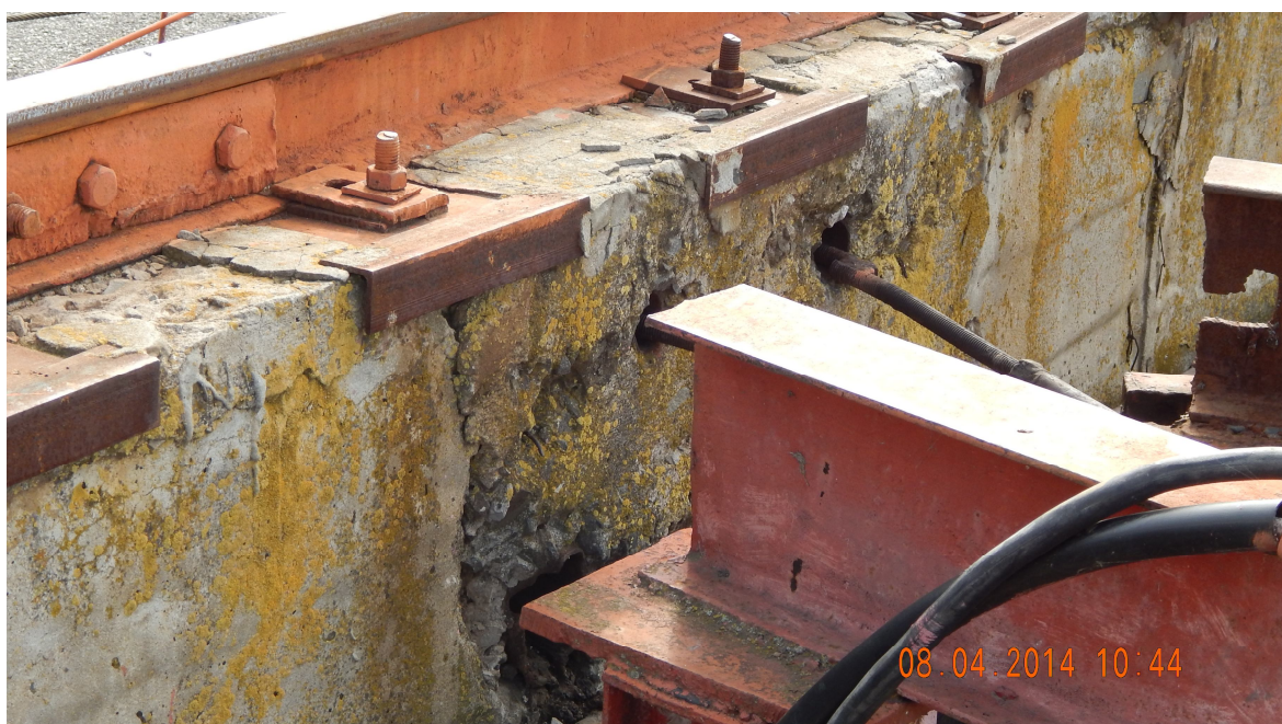
Рисунок 7 – Бетонные и стальные конструкции
