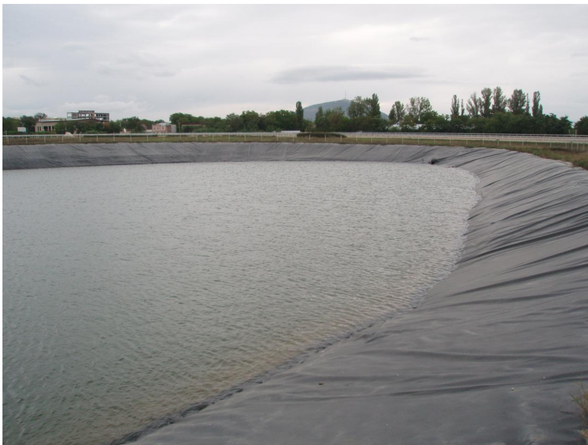
Рисунок 2 –Водоем-накопитель с поверхностным противофильтрационным экраном из геомембраны
