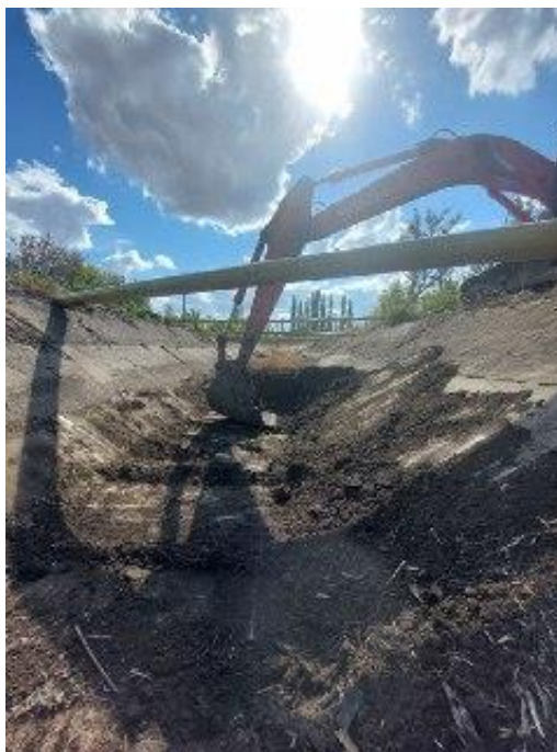
Рисунок 2 – Очистка оросительного канала одноковшовым экскаватором (автор фото О. А. Беляков)
