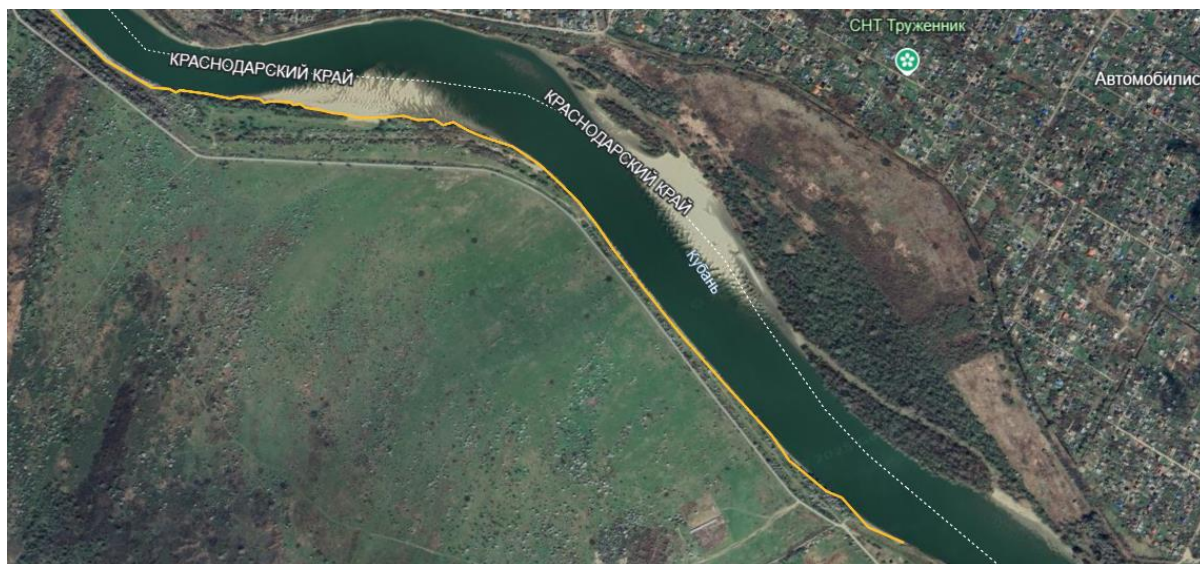
Рисунок 2 – Инженерная защита левого берега р. Кубань на ПК0 – ПК187
