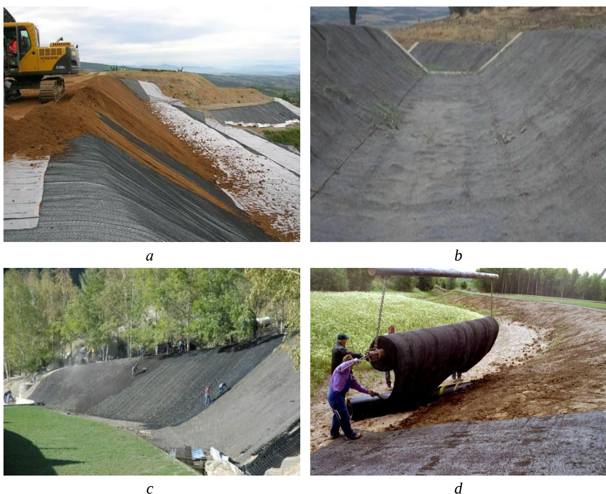
a, b – для укрепления дорожных кюветов, сбросных каналов; c, d – с биологическим типом укрепления, защита подтопляемых откосов земляного полотна [6, 7] a, b – for strengthening road ditches, discharge channels; c, d – with a biological type of strengthening, protection of flooded slopes of the roadbed [6, 7]
