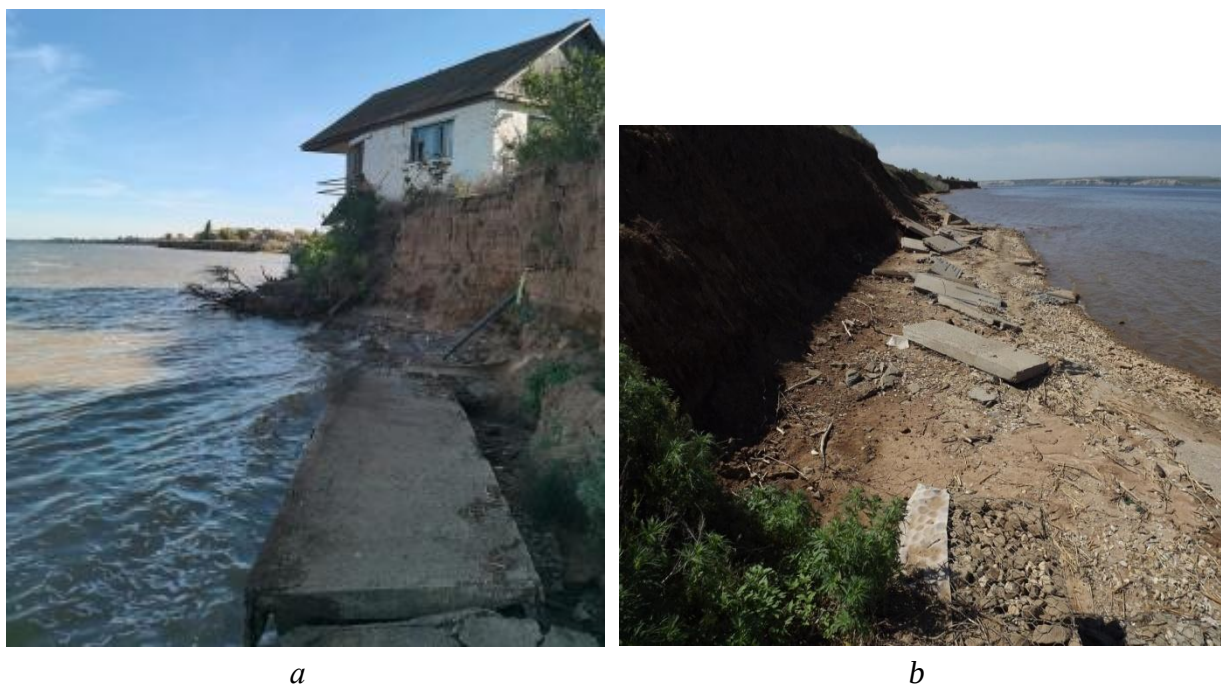
Рисунок 5 – Подмыв жилых строений (а) и неэффективные попытки «стихийного» локального берегоукрепления (b) (автор фото С. Я. Семененко)
