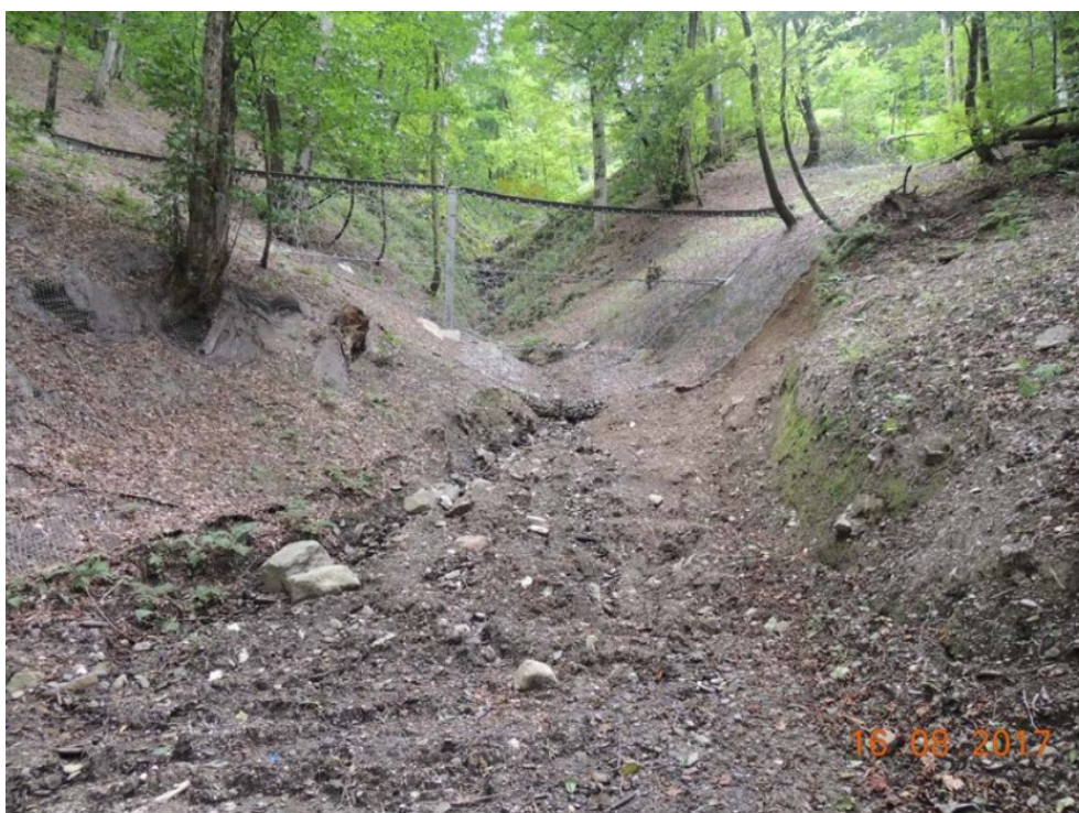
Рисунок 4 – Верхняя противоселевая сетка (автор фото У. Р. Сидаравичуте)
