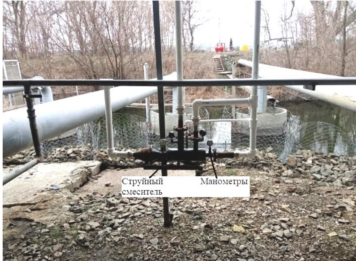
Рисунок 1 – Всасывающие трубопроводы насосной станции ООО «Рассвет» Куйбышевского района Ростовской области с установленным струйным смесителем и трубопроводами подвода животноводческих стоков. Общий вид (фото Ю. С. Уржумовой)
