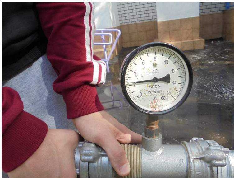
Рисунок 4 – Манометр в системе подачи смеси животноводческих стоков и воды. Общий вид (фото С. А. Тарасьянца)
