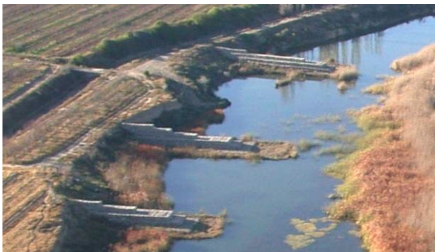
Рисунок 1 – Шпоры на вогнутом берегу р. Баффелджаги [6] Figure 1 – Spurs on the concave bank of the Buffeljags River [6]
